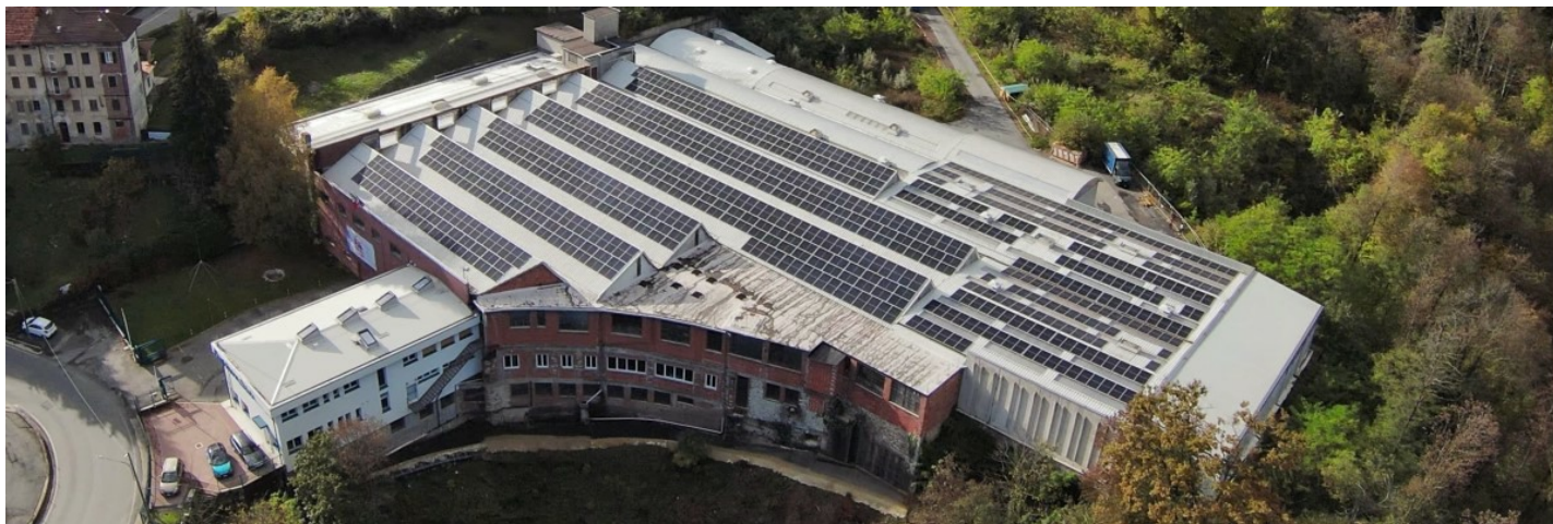
Una veduta dell'impianto nella sede di Valdilana
