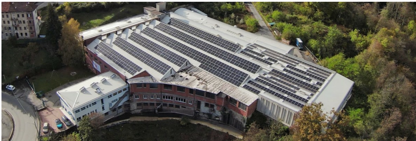
Una veduta dell'impianto nella sede di Valdilana
